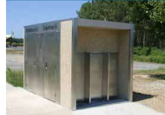
Doble cabina de aseo de forma rectangular con urinarios exteriores y mampara protectora
