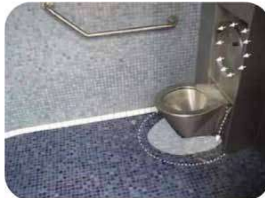
2.- Se limpia y desinfecta la tapa con agua y jabón a presión. A continuación se seca con aire caliente
