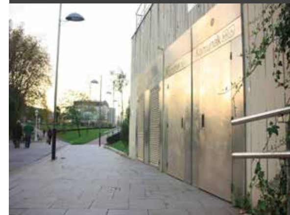
Acero inoxidable + hormigón
