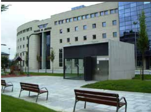
Acero inox. + planchas hormigón
