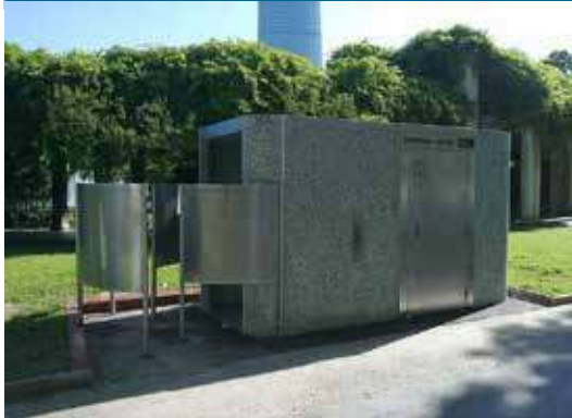
Cabina de aseo con cantos redondeados, urinarios exteriores y mampara protectora
