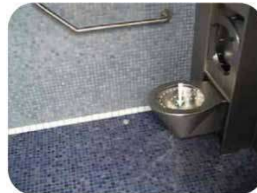
5.- Se limpia el interior del inodoro
